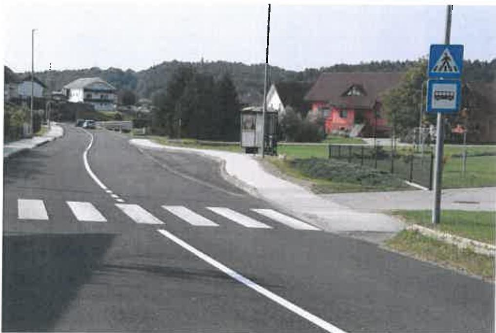
Avtobusni postajališči sta opremljeni z vertikalnima in talnima označbama. Avtobusi ustavljajo na odstavnem pasu državne ceste R229. Potniki imajo nivojsko ločen hodnik od cestišča. Obstaja pločnik in prehod za pešce med obema postajališčema. Hitrost je omejena na 50 km/h.
