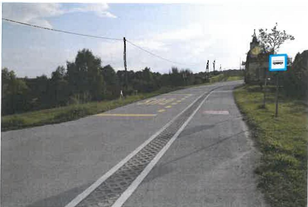
Avtobusni postajališči sta opremljeni z vertikalno in talno prometno signalizacijo. Postajališči sta dokaj nevarni, saj avtobus stoji na voznem pasu. Hitrost je na tem delu omejena na 50 km/h.
